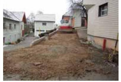
Mit einer Betonwand der Firma Eder wurde die Straße zum Hang hin abgestützt um ein Abrutschen zu verhindern.
