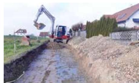
Im Spätherbst des Vorjahres erfolgte nach den Einbauten für die Glasfaseraufschließung die Erneuerung des Unterbaus bei einem Teilstück der Pfarrfeldstraße.
