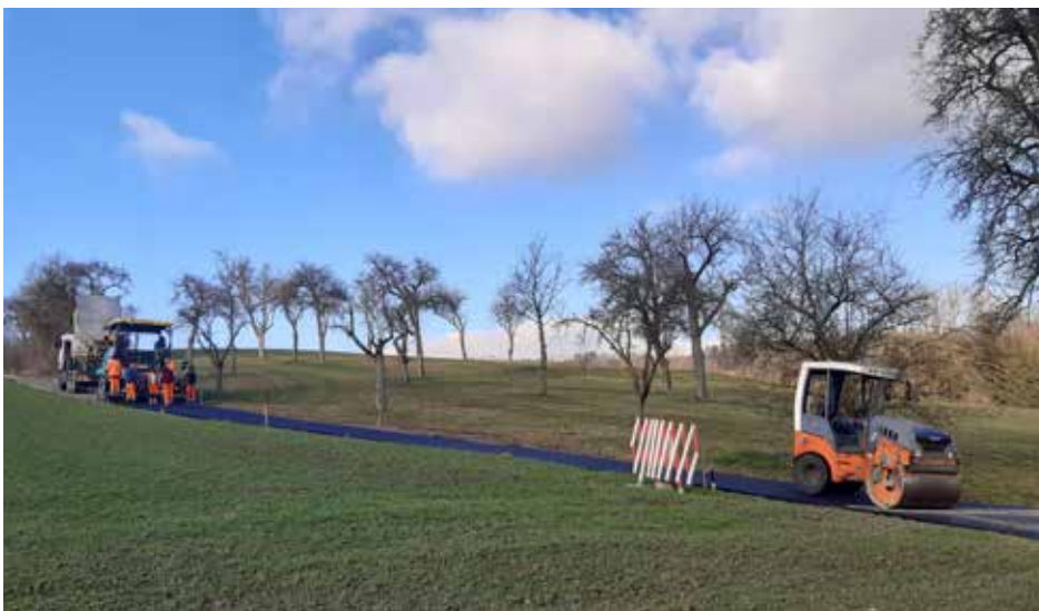
Straßenbauarbeiten im Schmidgraben.
