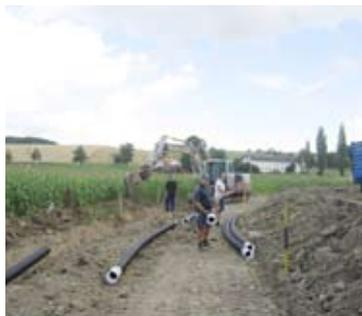
Im Bereich **Krumbach-Schömlahn** wurde eine weitere Drainage verlegt um den Schotterkoffer besser zu entwässern.
