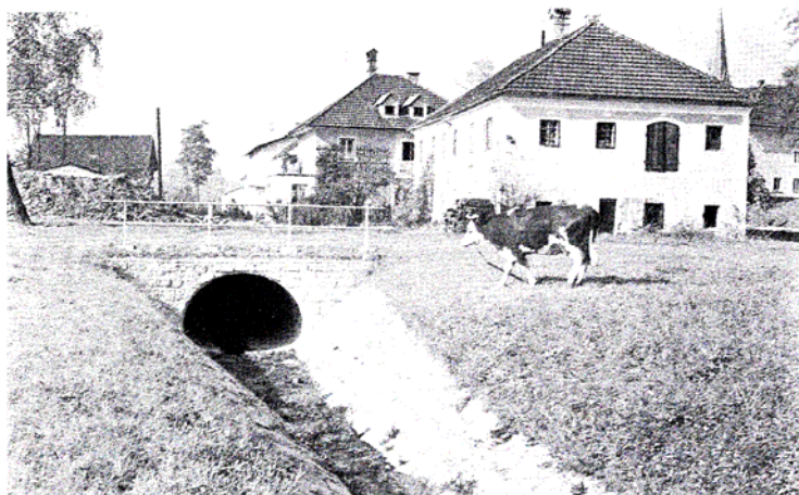
Mündung des Minithalbaches in den verrohrten Abschnitt. Das Schörgenhummerhaus wurde mittlerweile abgetragen
